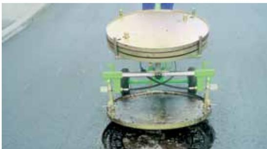
Nach dem letzten Walzengang wird das Abdeckblech herausgenommen. Als Aushebe- und Transportgerät dient der Universal-Schachtdeckelheber UDH-60. Mit den aufsteckbaren Zusatzklauen und einer Beladeeinrichtung können die Abdeckbleche leicht aus dem Straßenbelag ausgehoben und - bis zu 5 Stück - auf den UDH-60 aufgeladen und zu den Schachtabdeckungen vor dem Fertiger gebracht werden.
