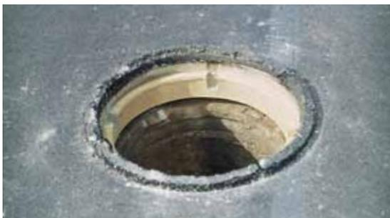
Nachdem der Belag erkaltet ist, wird der Schachtrahmen mit dem Rahmenheber MSRH-50 und dem dazugehörigen Zusatz-Schneidring auf das Straßenniveau angehoben. Dabei wird der über dem Schachtrahmen befindliche Belag so exakt abgeschert, dass keine Nacharbeit am Belag erforderlich ist. Nach dem Heben wird die Fuge unter dem Schachtrahmen mit Hilfe der Schlauchschalung und einem speziellen Flüssigmörtel vergossen.
