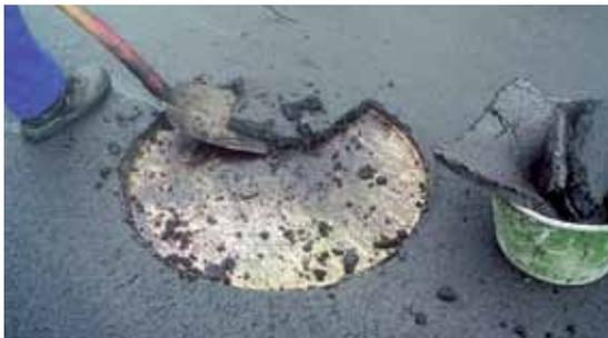
Nach ein- bis zweimaligem Walzen wird die Schachtabdeckung durch einen Abriss des Belags im Bereich der Abdeckblech-Umrandung sichtbar. Danach kann der Belag aus dem Abdeckblech entnommen und wieder verwendet werden. Das Abdeckblech muss unbedingt bis nach dem Fertigwalzen im Belag verbleiben.
